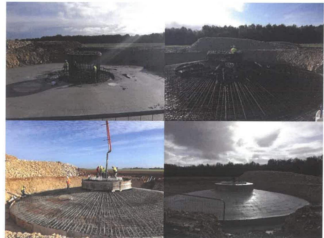
Figure 193 : Les principales étapes de construction d'une fondation pour une éolienne – Exemple du parc éolien en construction de Limalonges (Source : wpd onshore France)
